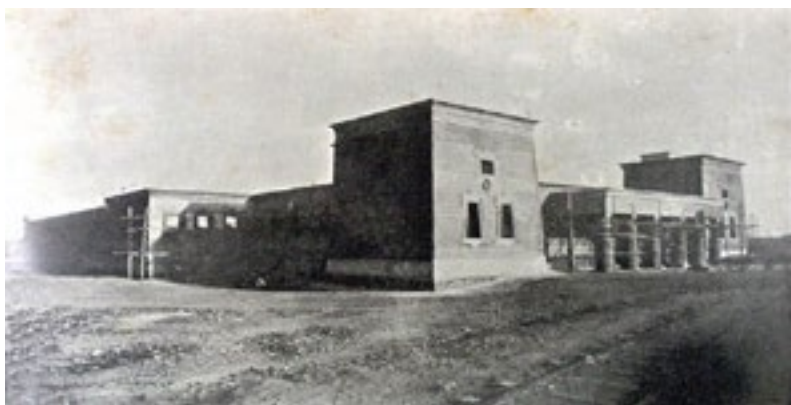
La Línea de Bella Vista con la edificación en construcción del antiguo retén de Maracaibo (Comp. Ebert Romero).
