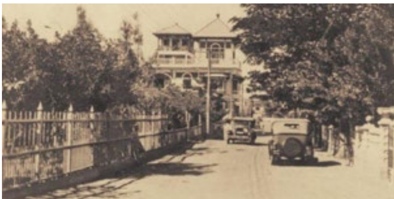
Antigua carretera o calle Unión
