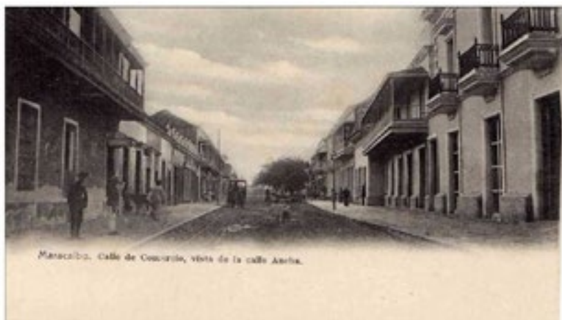
Maracaibo. Calle Comercio, vista desde la calle Ancha (Compilación. Ebert Romero)
