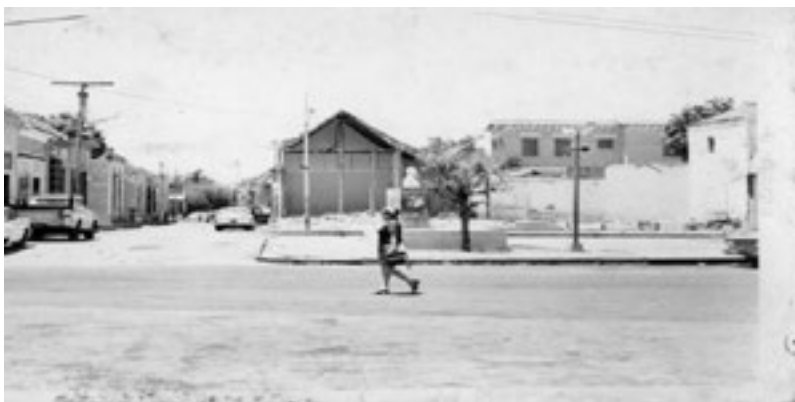
Una calle del Saladillo en los inicios del derrumbe del barrio (Comp. Ebert Romero)
