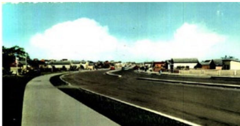
Construcción de Avenida La Limpia a principios de la década de los '50
